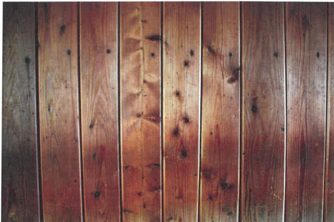
Slika 21: Opaž na steni v jedilnici. Foto: Saša Roškar, 2020. Hrani ZVKDS OE Kranj.
