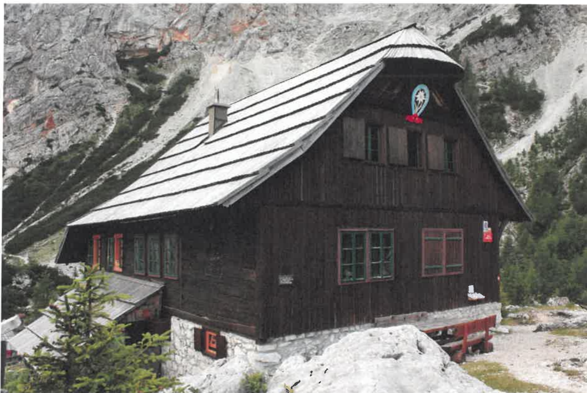
Slika 11: Severna in zahodna fasada. Foto: Saša Rožkar, 2020. Hrani ZVKDS OE Kranj.
